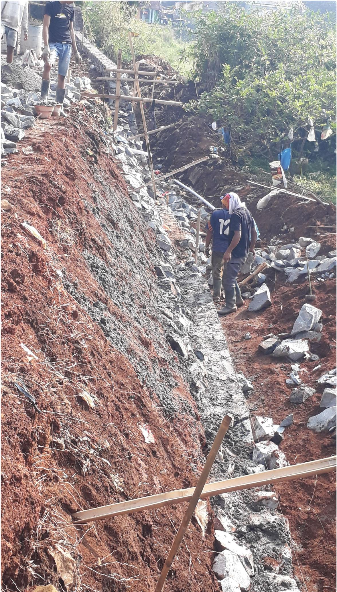
Keempat, adapun untuk metode pelaksanaan pekerjaan konstruksi saat pemasangan batu kali yang seharusnya merujuk ke gambar kerja membentuk sudut dengan bidang vertikal dari 0° sampai 450°.
